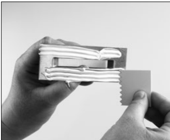
Fördela limmet över fästet
