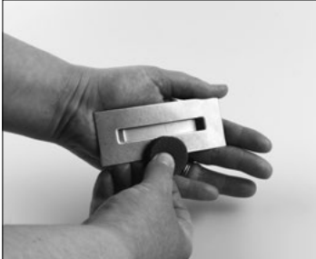
Starta med att rugga upp ytan på beslaget som ska fästas på spegelns baksida.
